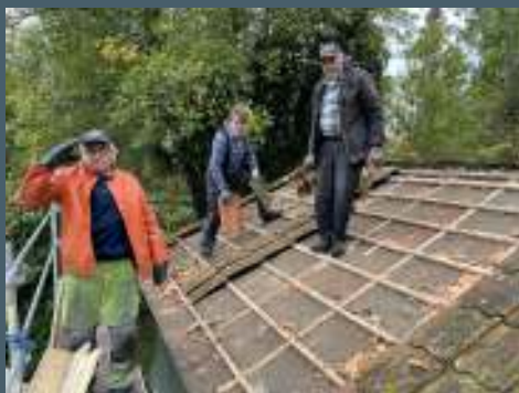
De gamla tegelpannorna på cafeterian tas bort. Sverker Schewenius, Ove Flodstrand och Ingemar Andersson.
