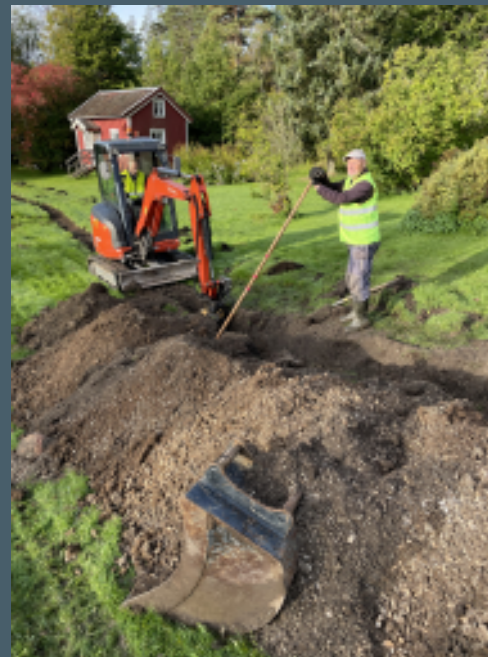
Håkan Eklund vid spakarna assisteras av Kurt Färdig när den nya vattenåledningen läggs.
