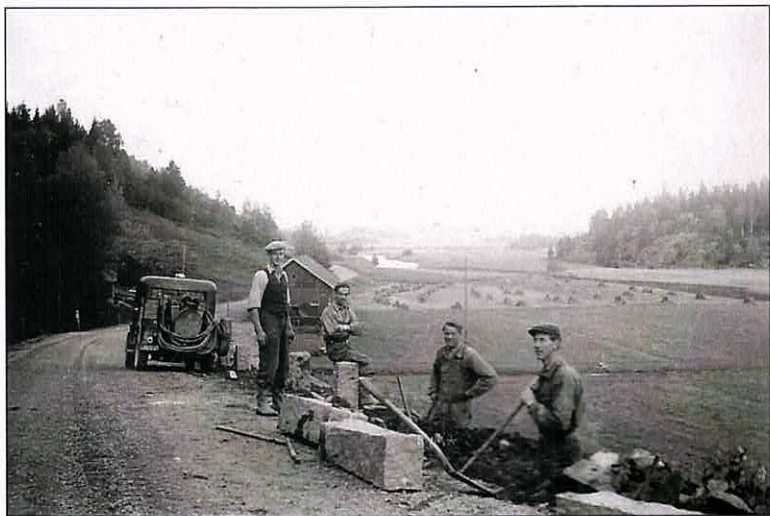
Ombyggnad av väg 940 i början av 1950- talet. Bilden är från backen vid Strömmane. Två från vänster Torsten Strandberg, övriga är okända.
